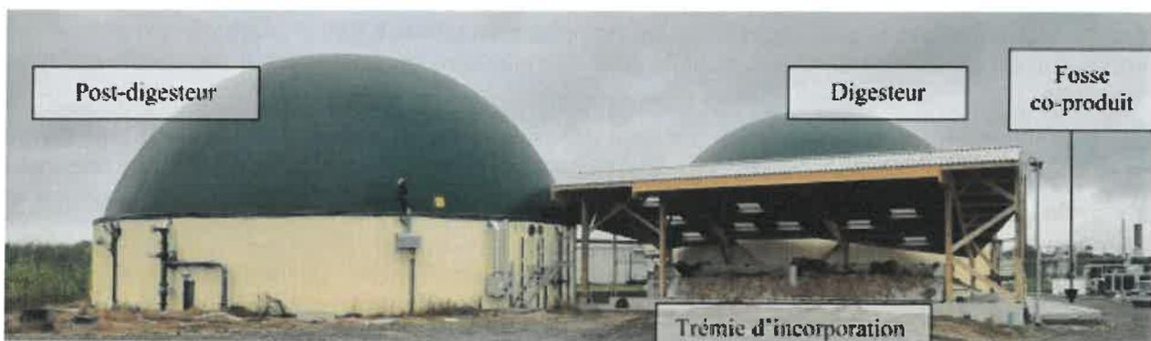
Figure 5 : Vue de la trémie du côté zone de déchargement
